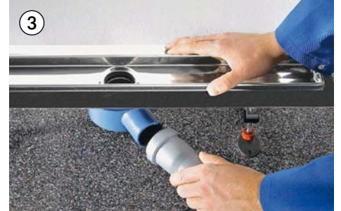
3. Anschluss der Abwasserleitung
