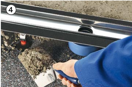
4. Einbau der Duschrinne und Verfüllen mit Estrich 5. & 6. Aufbringen der Abdichtung inklusive Dichtband (bauseits)
