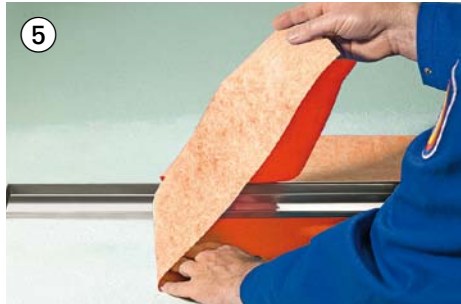
4. Einbau der Duschrinne und Verfüllen mit Estrich 5. & 6. Aufbringen der Abdichtung inklusive Dichtband (bauseits)
