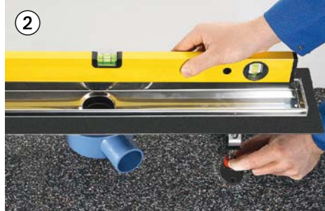
2. Ausrichten der Höhe mit der Wasserwaage
